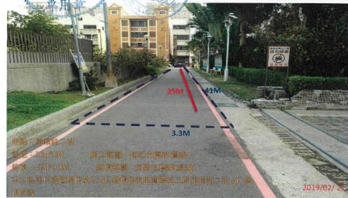
管控：35M*1M 施工範圍：如紅色標線(實線) 修復：41M*3.3M 修復範圍：如藍色標線(虛線) 修復範圍之前後依圖說前3米為主,若超出橫向路口,則修復鋪滿至該車道延長線,轉彎段依現地實際施工鋪滿
