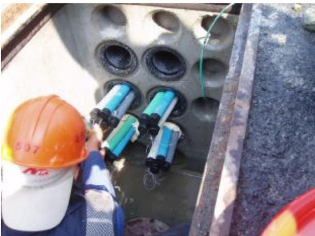
1. 管端固定時先用管口木栓將可撓管管口塞緊
